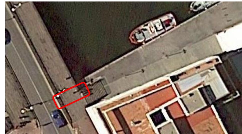
Figura 21: Afección escalera junto puente del barranco de San Nicolás
