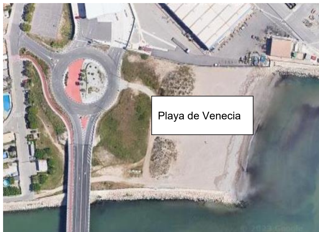
Figura 19: Foto con acceso sur finalizado y desafección y 5
